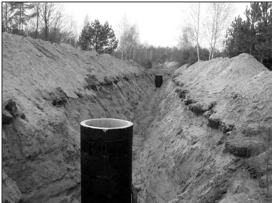
Kanal główny kanalizacji w Kaniowie południowym
