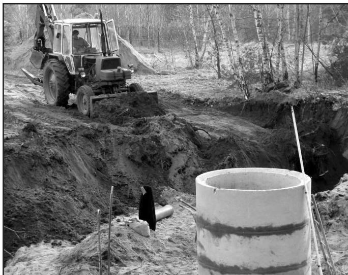
Budowa kanalizacji w Kaniowie południowym
